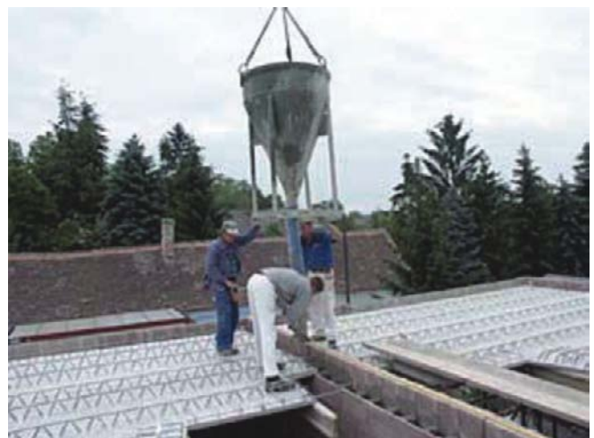
p. 2 Betonavimas bunkerio pagalba
