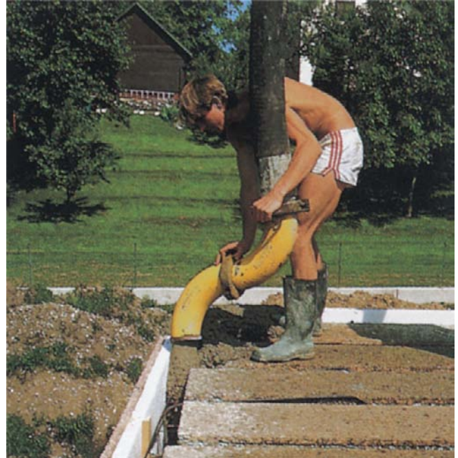
p. 1 Betonavimas siurblio pagalba
